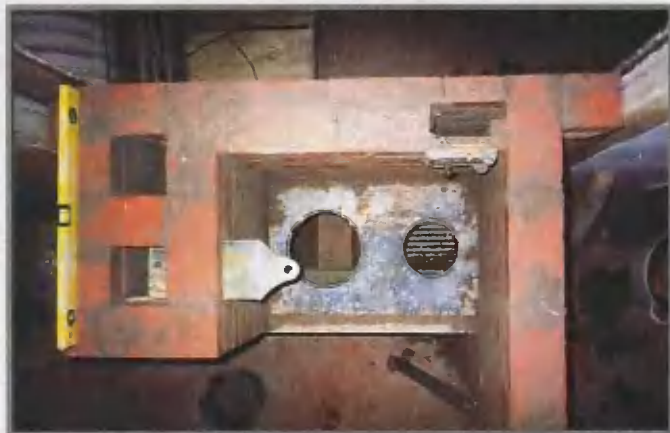
Уложен 19-й ряд кладки. Хорошо видны задвижка первого колпака, два дымовых канала и дверца вытяжки.
