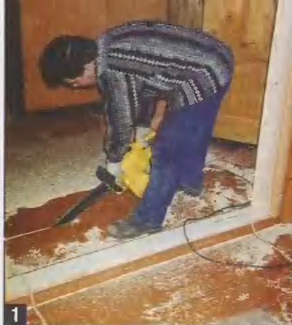
1 Для устройства фундамента печи пришлось вскрыть пол. Благодаря применению электроинструментов такая задача решается очень просто.
