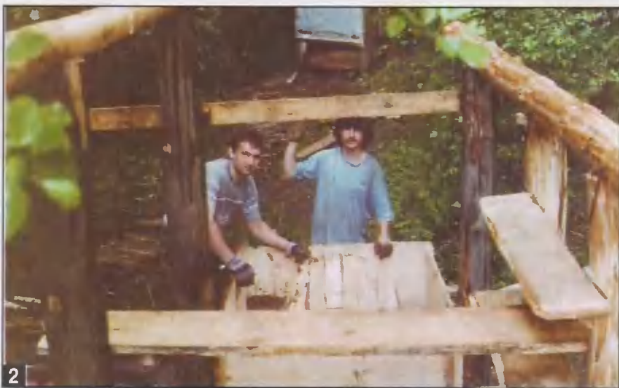
2 На устройство внешней и внутренней опалубки ушел целый день.
