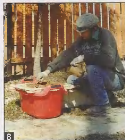
8 Глину предварительно замачивают и размешивают в отдельной емкости (бочке, деревянном ящике, большом пластмассовом тазу).
