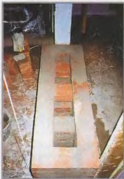
Вкладочные кирпичи во втором ряду кладки большого колпака выше уровня пола второго этажа.
