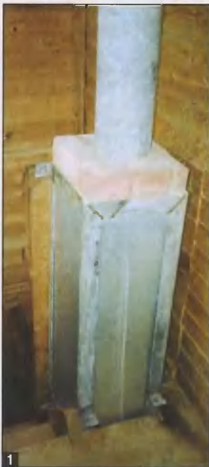
Термоизолирующий переходник в проеме размером 30х30 см.
