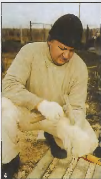
4 Необработанные поверхности ложковой стороны протесывают тем же молотком-кирочкой.
