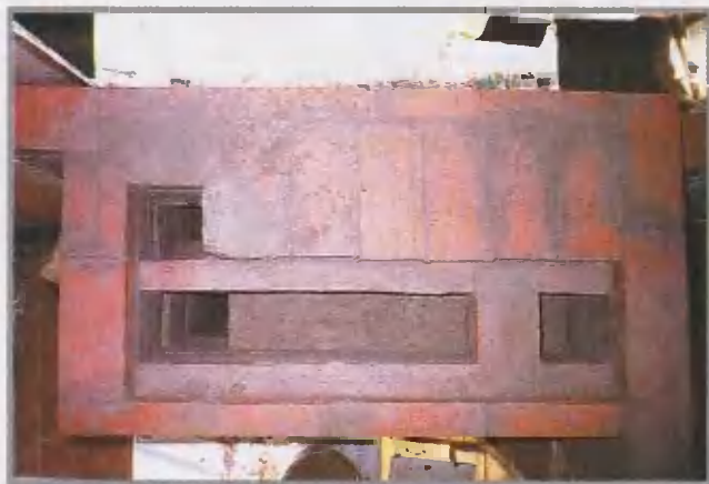
Перекрытие колпаков первого этажа.
