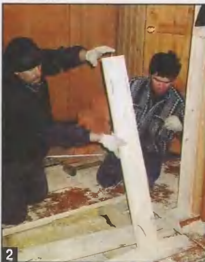
2 Правильно построенный дом обычно имеет двойные полы: чистые — верхние и черновые — нижние, между которыми проложен утеплитель. (Момент разборки пола).
