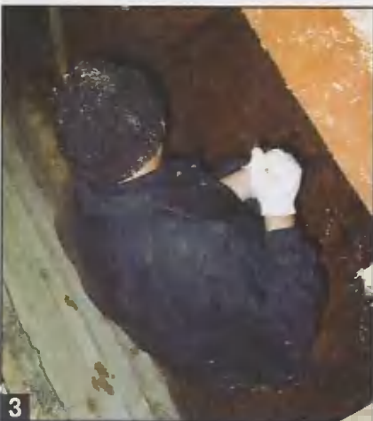
3 Почва под будущей печью оказалась глинистая, поэтому рыть котлован под фундамент пришлось на глубину в три штыка лопаты (около 75 см).
