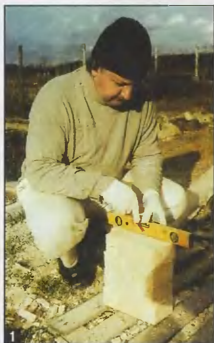
1 На плашечной и тычковой стороне карандашом прочерчивают линию — контур обработки кирпича. Шаблоном для этого служит рейка определенной толщины, в нашем случае — строительный уровень.
