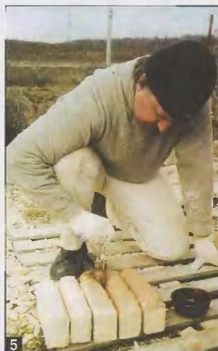
5 Кистью на обработанную сторону наносят краску (морилку) на водной основе
