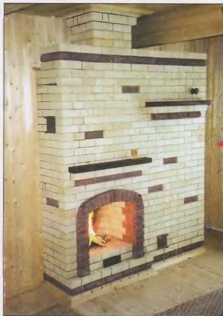
Печь-камин, отделанная тонирующим кирпичом, отесанным под «дикий камень».
