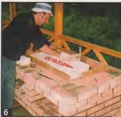
Подина топливника выкладывается «насухо» с термическими швами. В качестве прокладок, удаляемых впоследствии, устанавливают картонные прокладки.
