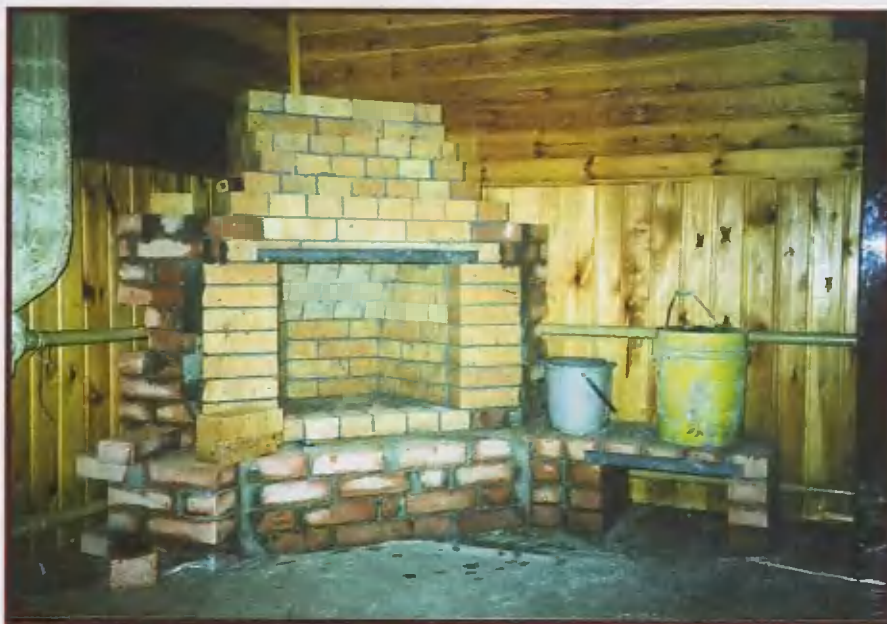
Промежуточный этап кладки камина.
