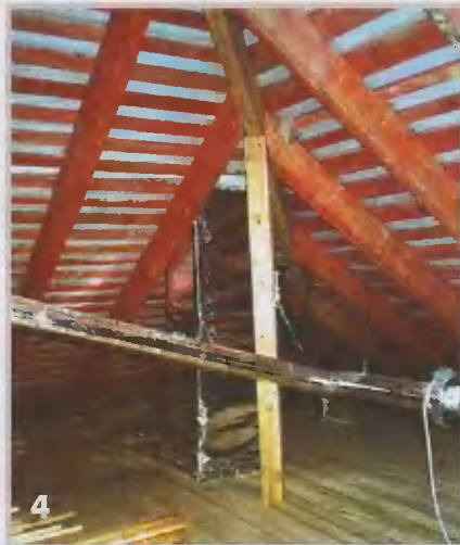
Утепление трубы в чердачном помещении позволит избежать «запотевания» ее наружной поверхности и сохранить кладку.
