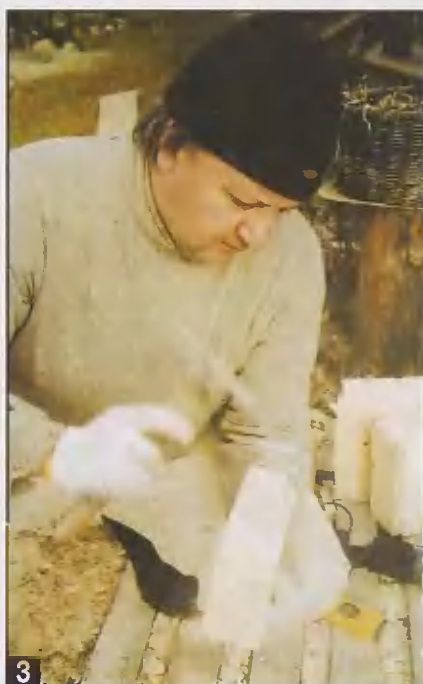
3 Молотком-кирочкой скалывают усенки (ребра) кирпича по всей ложковой стороне.
