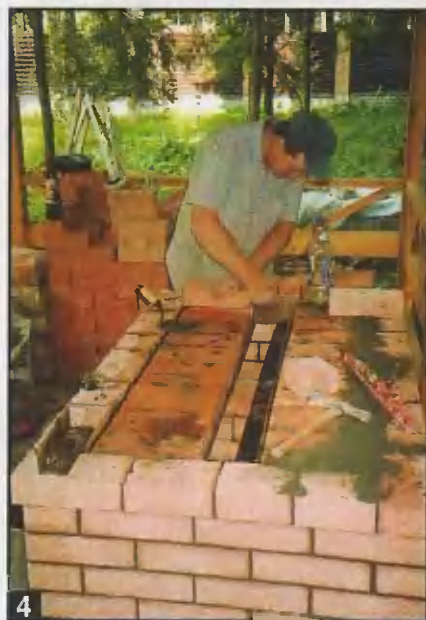
Лицевая кладка из отделочного кирпича цвета «абрикос». Перекрытие ниши для хранения посуды осуществляется с помощью металлических уголков. В качестве забутовки применяется полнотелый кирпич.
