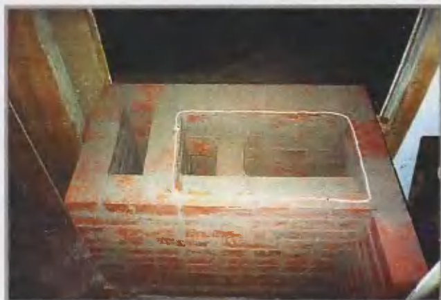
Под чугунную варочную плиту для уплотнения щели прокладывают асбестовый шнур.
