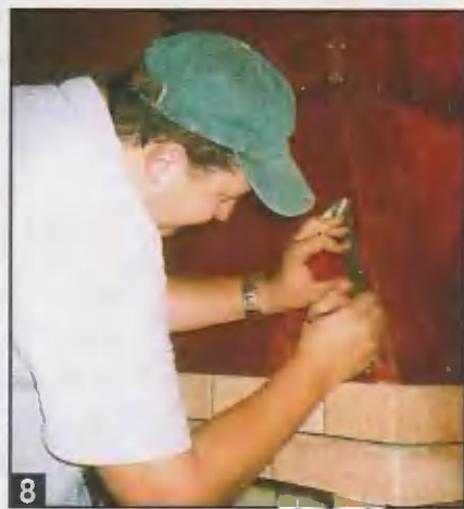
Фальш-короб представляет собой каркас из стальных оцинкованных профилей с укрепленными на заклепках медными листами.
