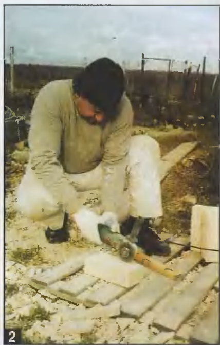
2 С помощью углошлифмашинки по этой линии прорезают бороздку глубиной 4–5 мм.
