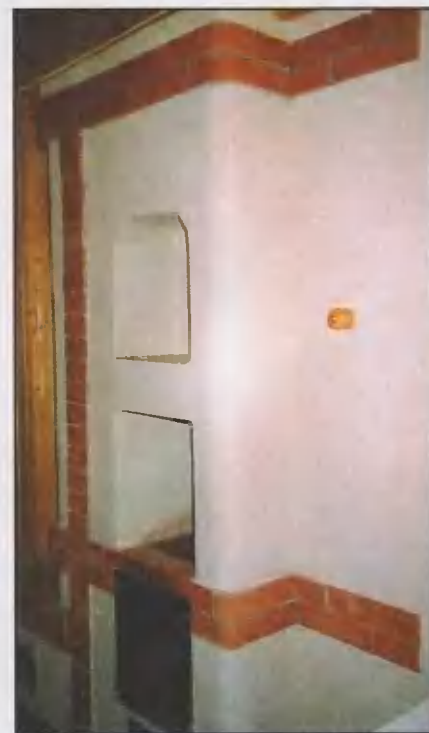
Отопительно-варочная печь оштукатурена по армирующей сетке.
