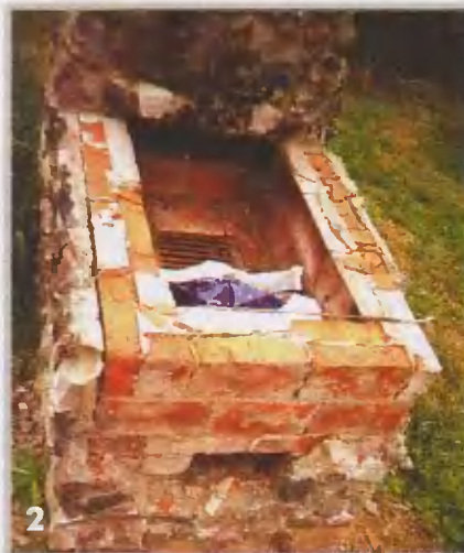
Уличная шашлычная печь под воздействием осадков и перепадов температуры разрушилась за один сезон.
