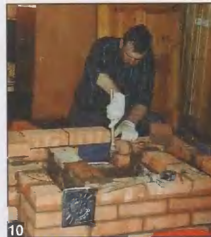
10 Зольная камера, располагаемая под топкой, служит для сбора золы и несгоревших частиц топлива. На фото показан момент перекрытия поддувальной дверки.
